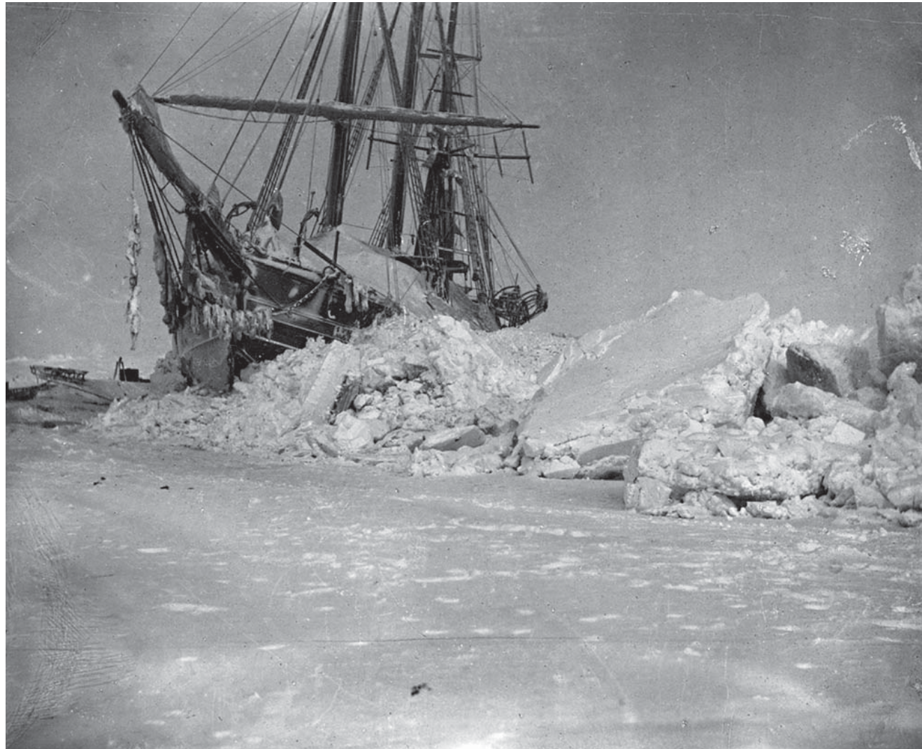
10. Januar 1895: Die «Fram» treibt unbeschadet durch und über das Packeis. Dank seiner Bauweise wird das Schiff vom Eis herauf- statt heruntergedrückt.
