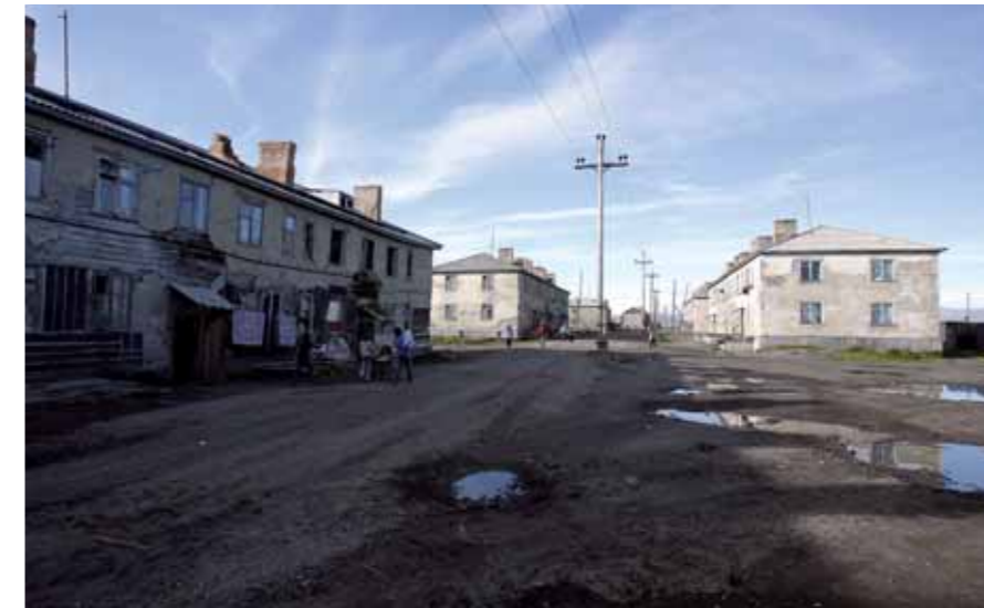
Die Siedlung von Lorino macht einen ziemlich trostlosen Eindruck. Viele Häuser zerfallen oder sind beschädigt, die Strassen sind voller Schlaglöcher.
