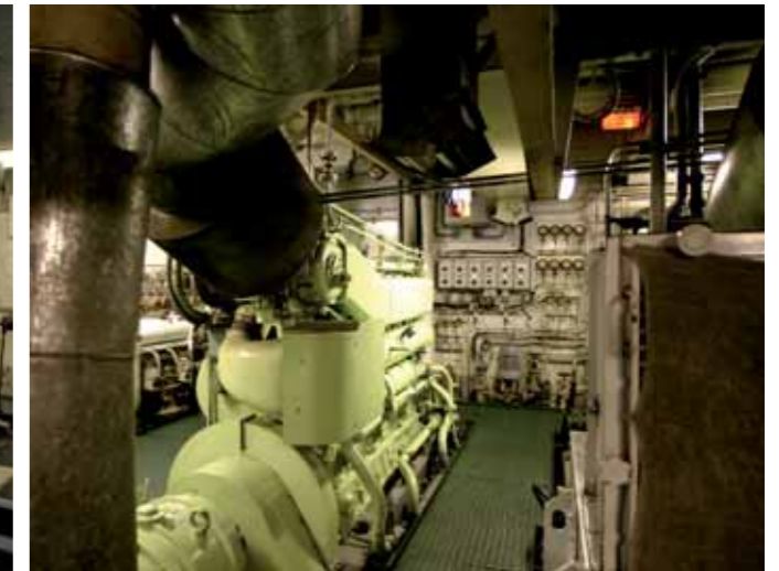
Im Maschinenraum ist von den Elektrodiesel-Motoren so gut wie nichts zu sehen. Von Kohle-Schaukeln-Romantik à la «Titanic» keine Spur.
